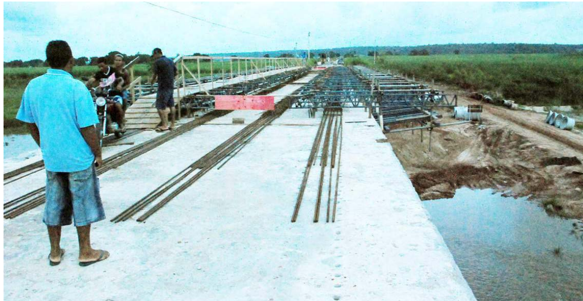
Os serviços de alargamento da ponte, localizada entre Santa Rita e Espírito Santo, estão em ritmo acelerado
